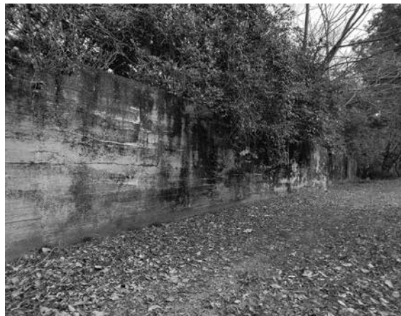
恵楓園の西側と北側に今も残る「隔離の壁」 （令和5／2023年1月撮影）
