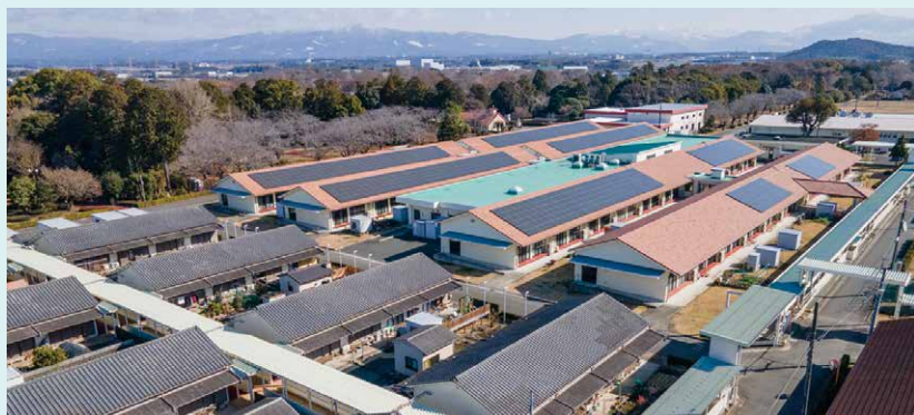
上空から見た一般寮（手前の瓦屋根の建物）とその奥にあるセンター 2024（令和6）年
