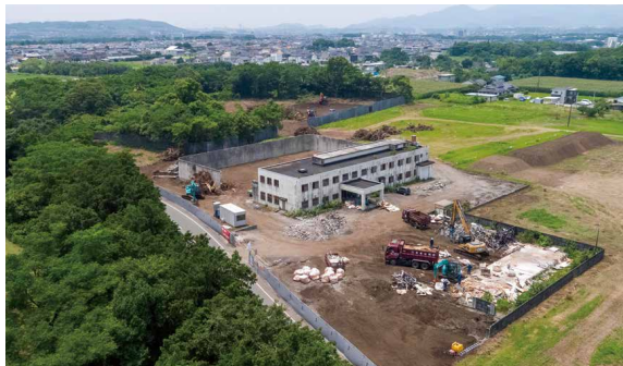
解体される菊池医療刑務支所 (P.57 参照) 2019 (令和元) 年 医療刑務支所はらい予防法が廃止された1996年に閉鎖された
