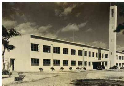
事務本館 1955（昭和30）年ごろ 事務棟と医局、研究室が一つにまとめられた施設。 現在は菊池恵楓園歴史資料館本館となっている
